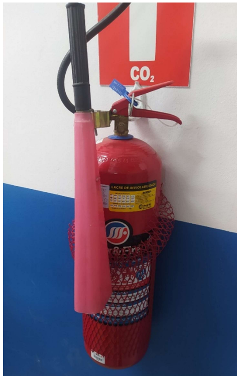
Figura 27 - Extintor com a carcaça em bom estado
