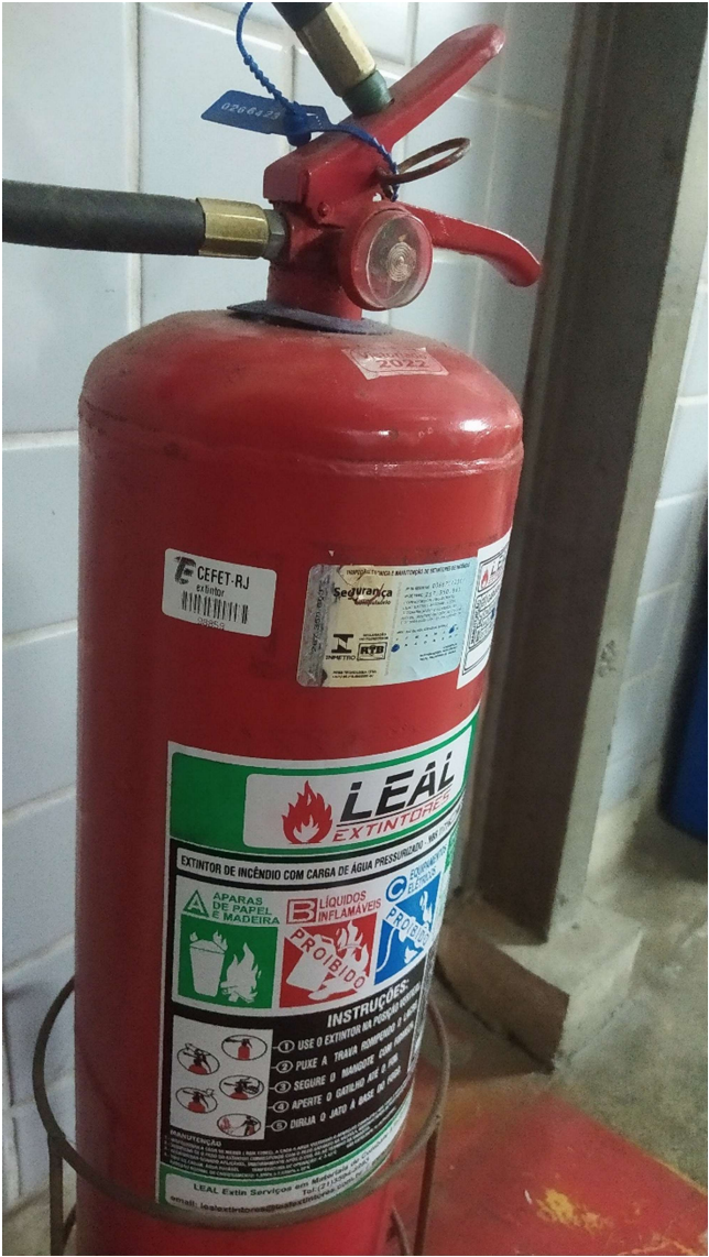
Figura 39 - Extintor empoeirado
