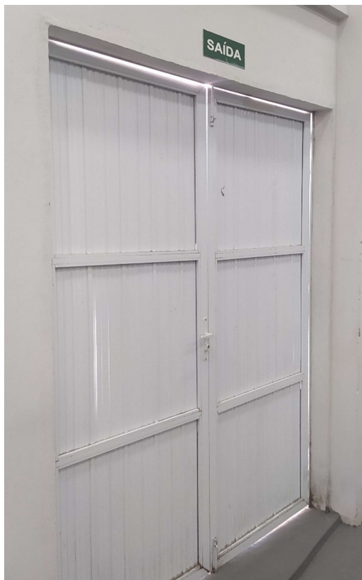
Figura 23 - Sinalização da saída de emergência do auditório de VA
