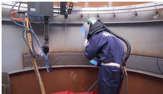
Fig. 7 - Processo de cladeamento por soldagem Sulzer (Weld overlay)
