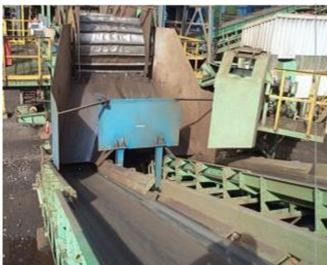
Figura 38: Transportadores de correia paralelos
