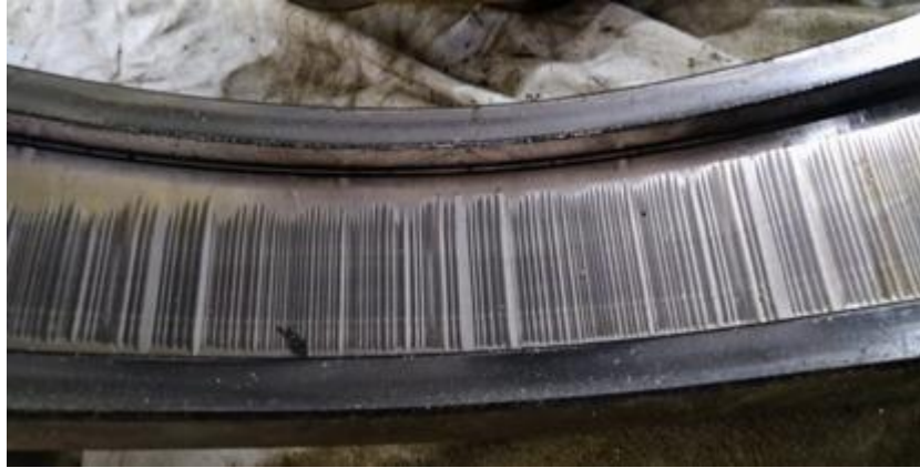
Figura 63: Corrosão Elétrica na pista externa do rolamento do lado livre
