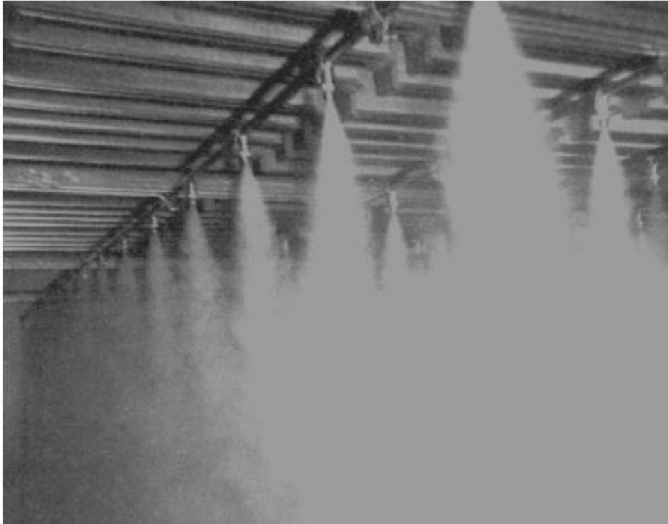
Figura 29: Bocais utilizados no resfriamento evaporativo por nevoa [2]
