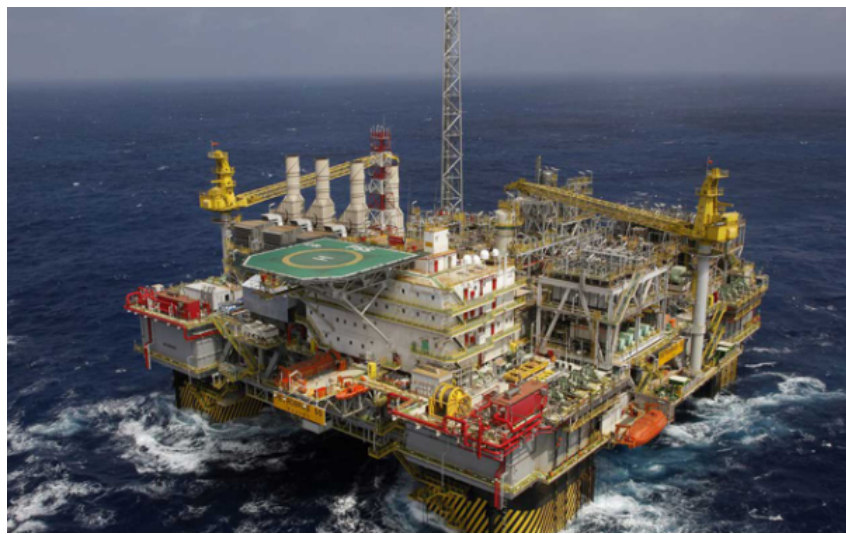
Figura 8: Exemplo de unidade de produção SS. Fonte: [P&Q, 2019]
