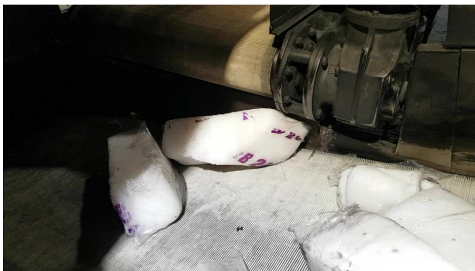
Figura 44 – Substituição da Estrutura TE36/37
